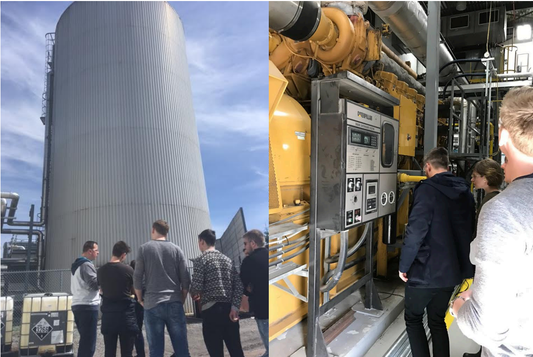
Craig Graham greiðir frá, hvussu Markham District Energy megnar at gagnnýta akkumulatortanga til heitt vatn og stýriskipanina til motorarnar.
