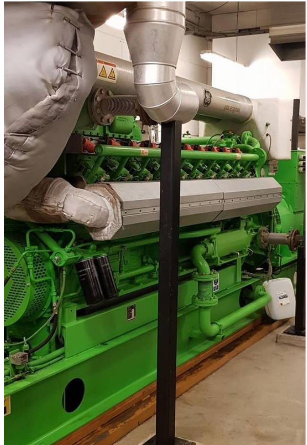
Figur 8. Vísur gassmotor sum koyrur uppá gassi í verður framleitt á verkinum og drívur ein generator til el framleiðslu.
